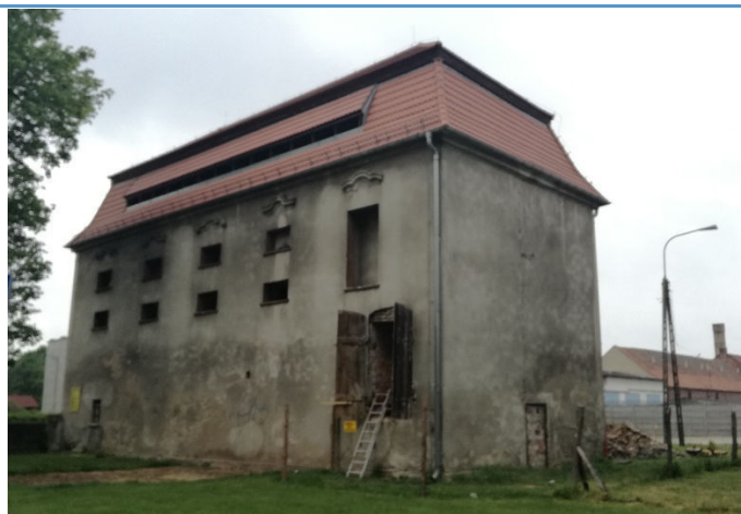
Spichlerz przed renowacją
