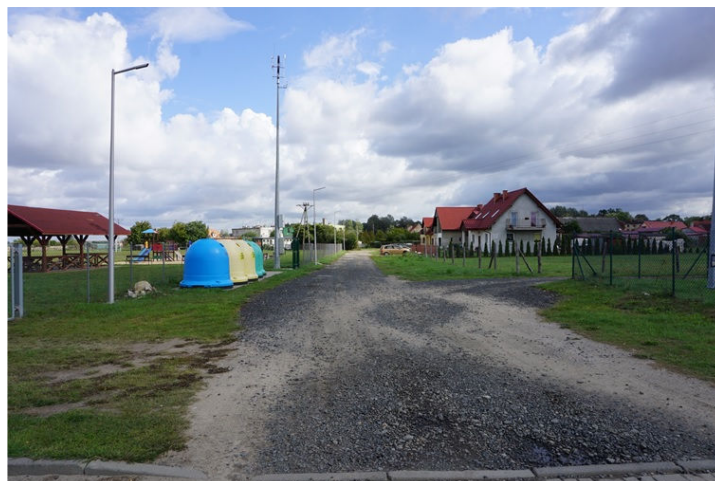
Droga przed remontem
