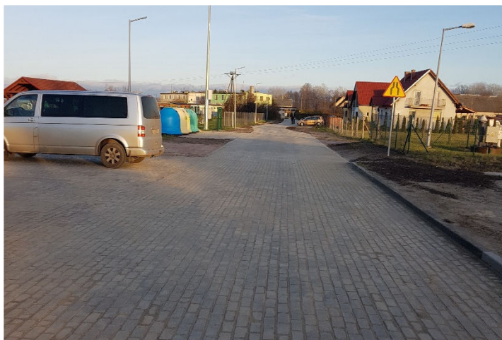
Droga po przebudowie
