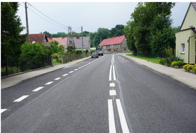
Droga w Retkowie po remoncie
