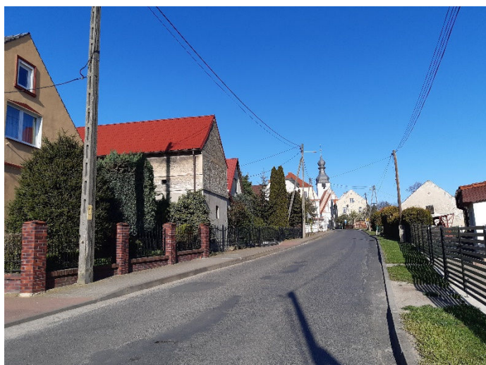
Droga w Kwielicach przed remontem
