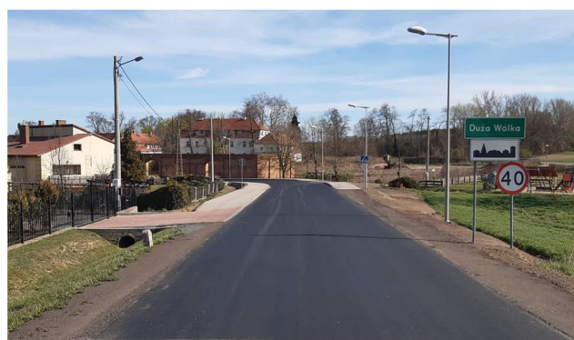
Droga powiatowa w miejscowości Duża Wólka przebudowana na przełomie 2019/2020 roku
