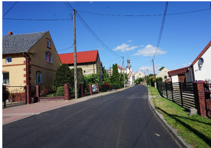
Droga w Kwielicach po remoncie
