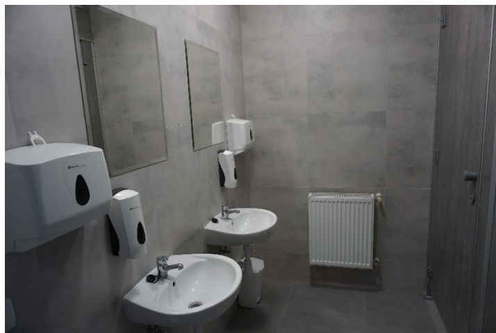
Sanitariat damski po remoncie
