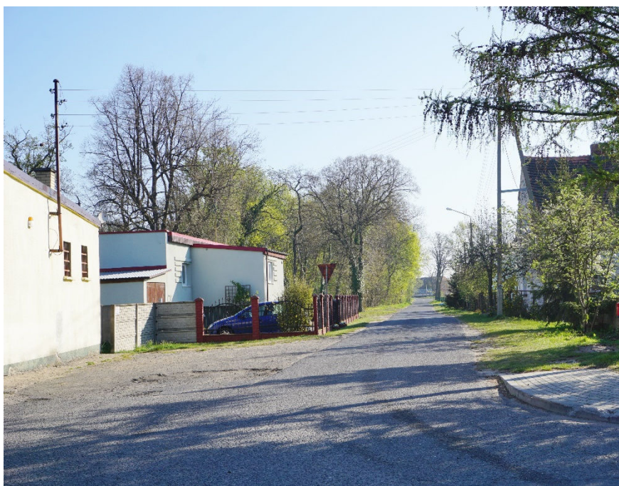
W Rzeczycy dokończony zostanie ostatni etap przebudowy drogi gminnej
