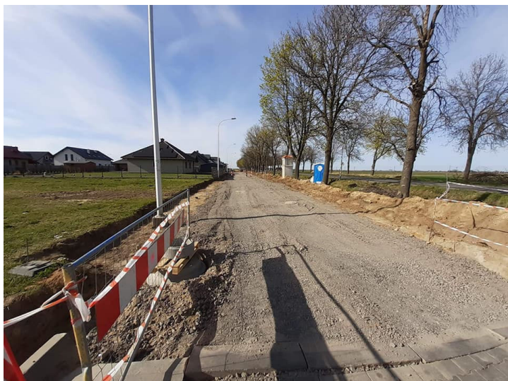
W trakcie remontu jest ul. Azaliowa
