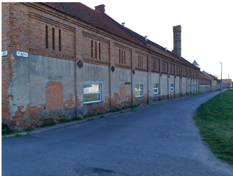
Wyremontowana będzie droga przy ul. Krótkiej w Grębocicach
