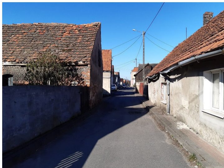
Remont przejdzie ul. Wąska w Grębocicach
