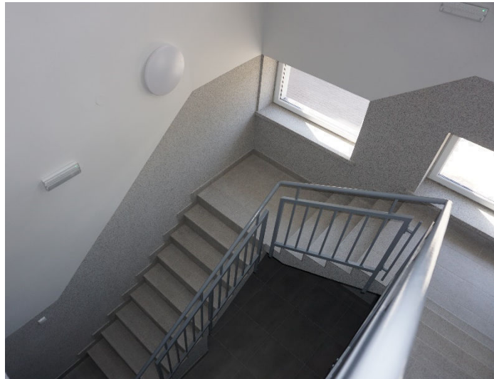
Klatka schodowa po remoncie
