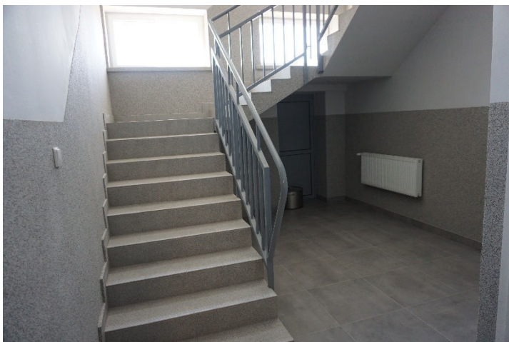
Klatka schodowa po remoncie
