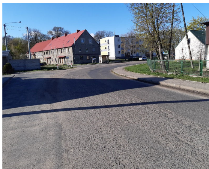
W Retkowie rozpoczął się remont drogi powiatowej
