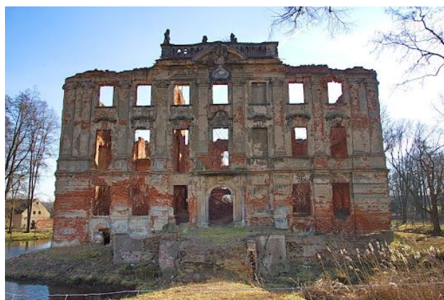
Zdjęcie 6 – Ruiny pałacu w Krzydłowicach
